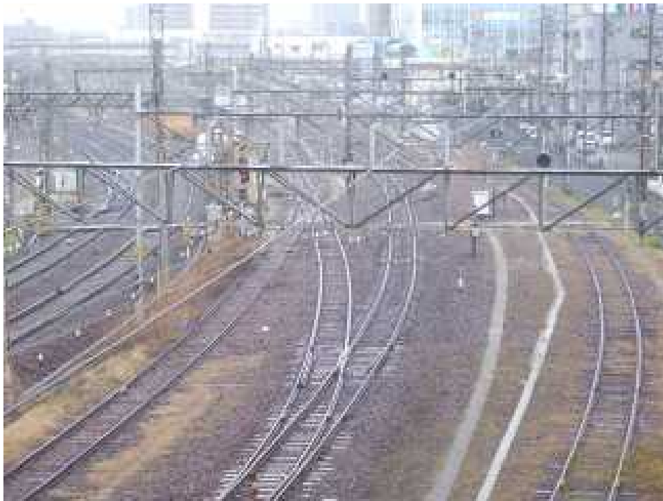
近鉄1435mm JR関西線1067mm 三岐鉄道762mm (左側 複線部分) (中央 複線部分) (右側 単線部分)
